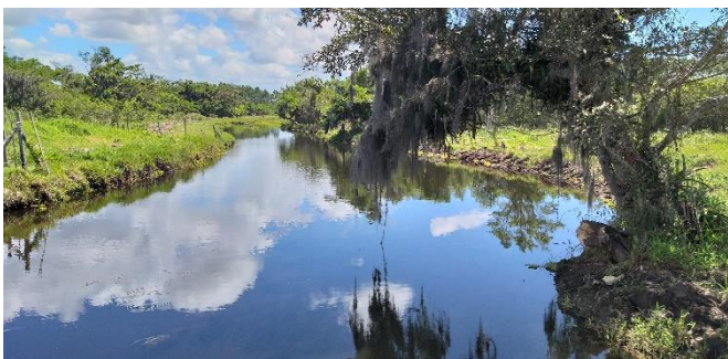
Figura 8: Captação Estiva do Rodrigues – Setor montante à barragem.
