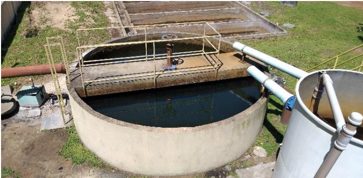
Figura 45: Decantador – vista geral - sistema hidráulico do lodo proveniente dos filtros de ambos os módulos de tratamento de água.
