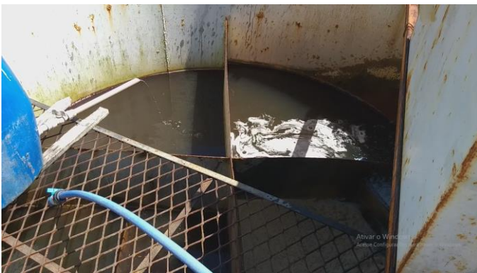
Figura 38: Floculador – sistema de chicanas
