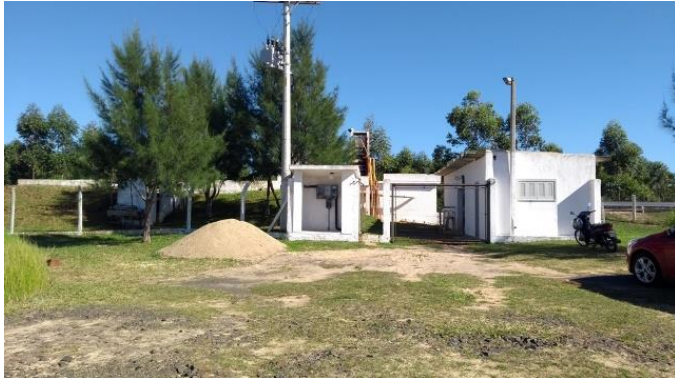
Figura 103: ETA – Vista Frontal
