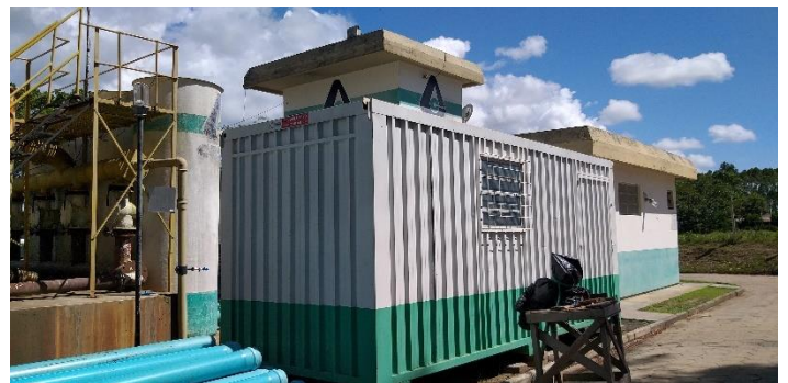
Figura 63: Depósito de produtos químicos -Vista geral.
