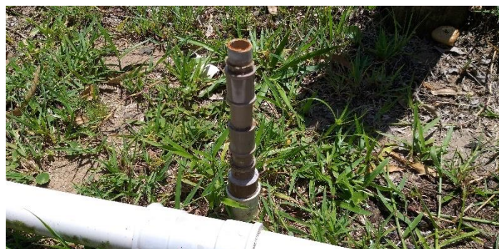
Figura 15: Sistema de ponteiros – ponteira típica.
