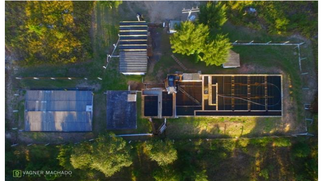
Figura 104: ETA – Vista superior
