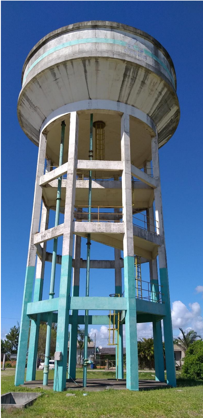
Figura 91: Reservatório elevado – vista geral.
