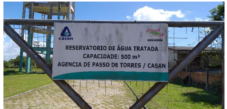
Figura 92: Reservatório elevado – placa de identificação
