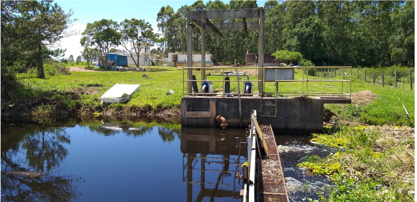
Figura 5: Captação Estiva do Rodrigues – Vista da ETA aos fundos.
