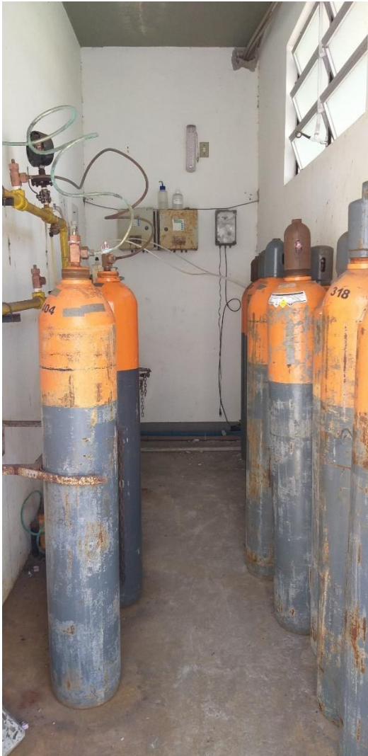
Figura 58: Casa de Cloro – vista geral.
