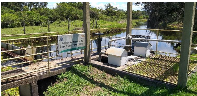
Figura 6: Captação Estiva do Rodrigues – Vista Geral
