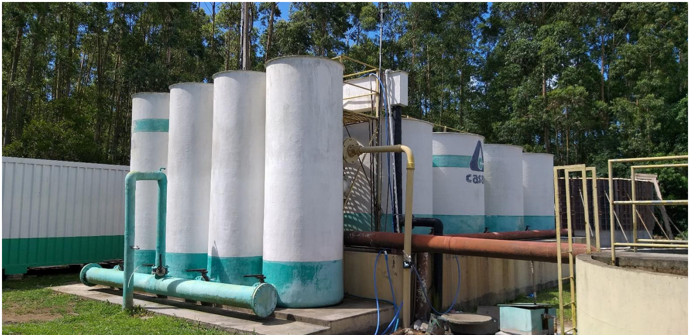
Figura 20: ETA – Módulo Compacto Aberto em Fibra –Capacidade de produção: 12,4 L/s.
