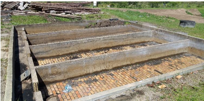
Figura 47: Leitos de Secagem do lodo – vista geral.
