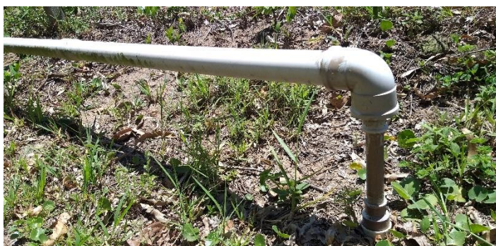
Figura 16: Sistema de ponteiros – interligação ao barrilete principal.
