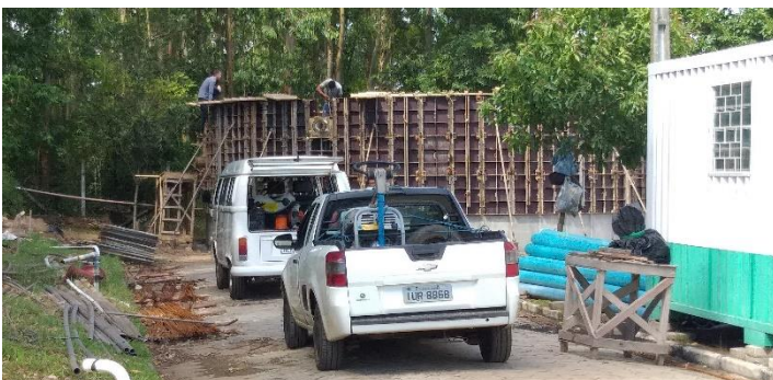
Figura 81: Vista geral das obras do reservatório
