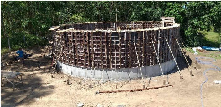
Figura 80: Vista geral das obras do reservatório
