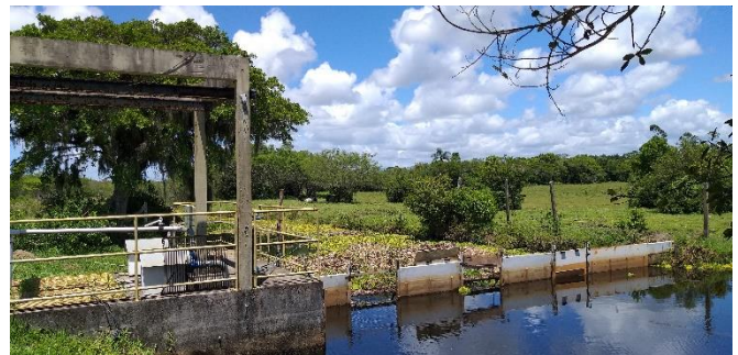
Figura 7: Captação Estiva do Rodrigues – Estação de recalque e barragem de nível
