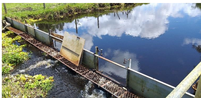
Figura 12: Estruturas do barramento.
