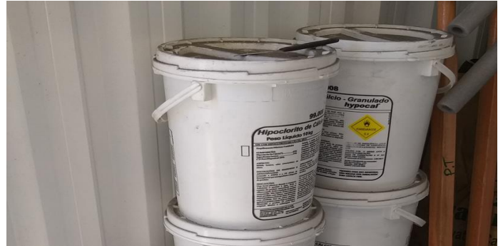
Figura 69: Depósito de produtos químicos -Hipoclorito de Sódio.
