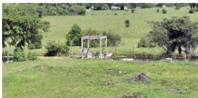
Figura 13: Visão ampliada das estruturas de captação.
