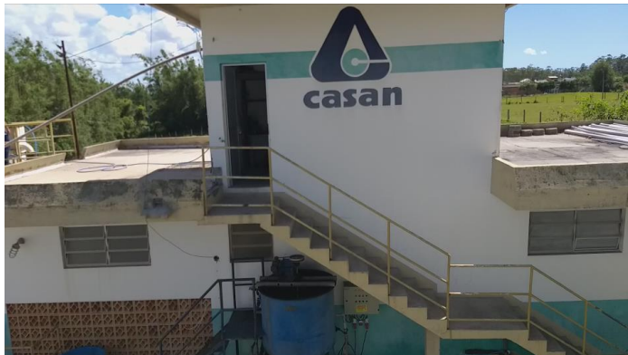
Figura 75: Sala de dosagem de produtos químicos – misturador de carvão ativado.
