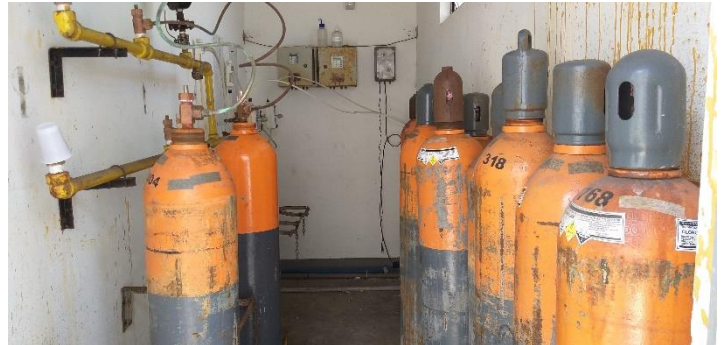
Figura 59: Casa de Cloro – vista geral.
