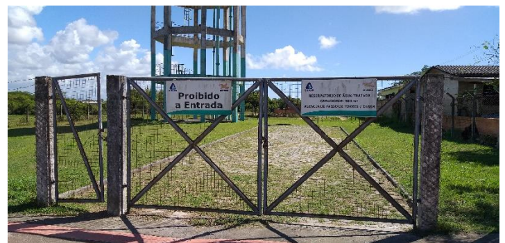
Figura 93: Reservatório elevado – Placas de identificação e advertência.
