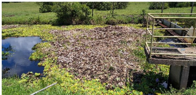
Figura 11: Captação Estiva do Rodrigues – Setor jusante à barragem. Grande quantidade de plantas aquáticas sobrenadantes.
