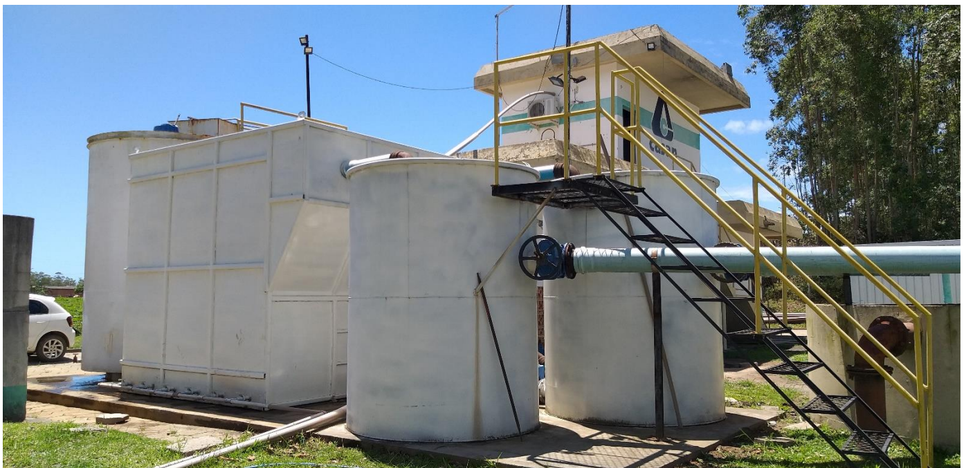
Figura 21: ETA – Módulo Compacto Aberto em Aço Inox - Capacidade de produção: 9,5 L/s.
