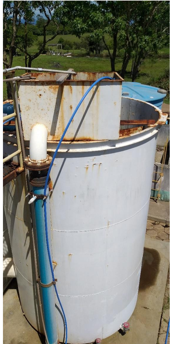
Figura 39: Floculador com caixa de chegada de água acoplada.
