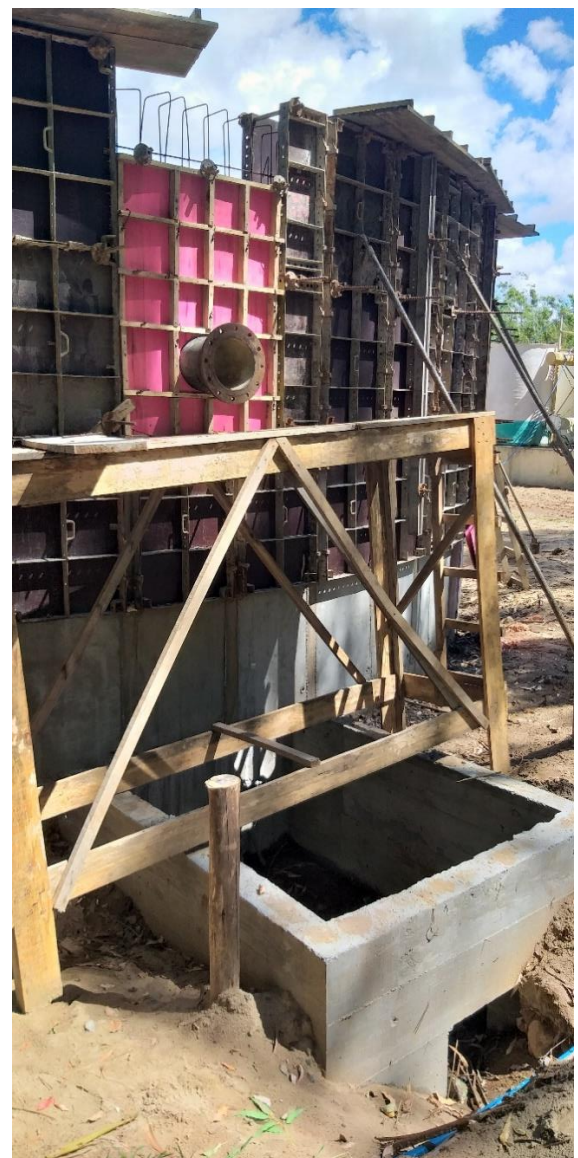
Figura 82: Vista geral das obras do reservatório com destaque para a caixa de manobras.
