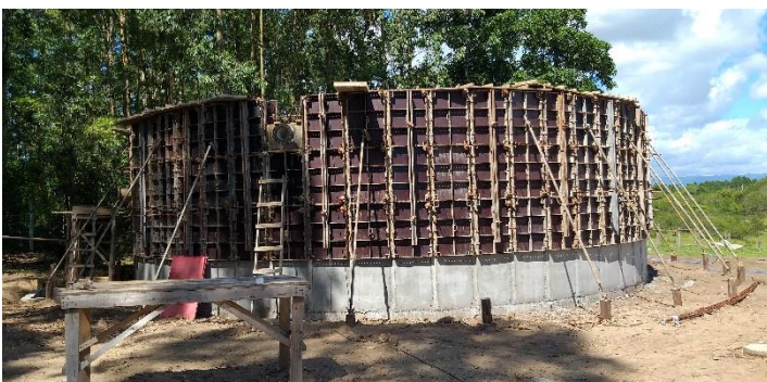
Figura 79: Vista geral das obras do reservatório
