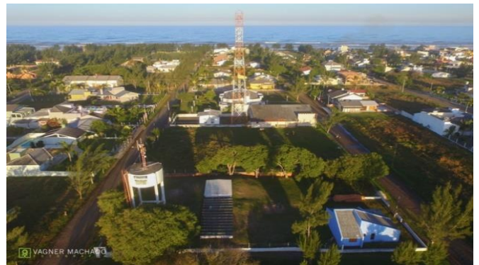
Figura 106: Vista panorâmica do loteamento Bella Torres.
