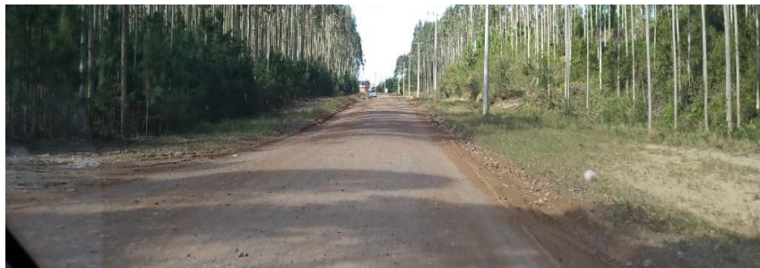
Caminhos do Mar – Km 7+600:
