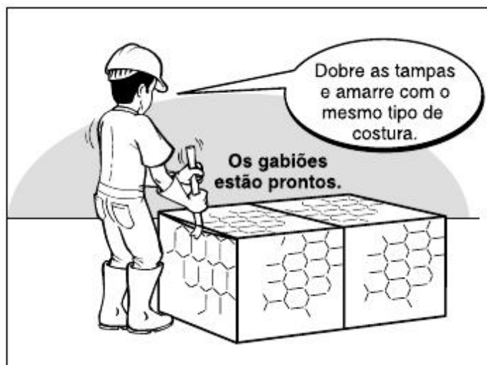
Fig.15 - Detalhe da etapa de fechamento do gabião tipo caixa
