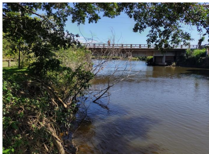
IMAGEM 02 - VISTA LATERAL DA PONTE
