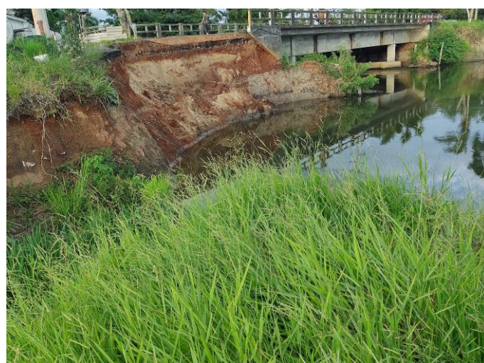
IMAGEM 04 - VISTA LATERAL DA PONTE
