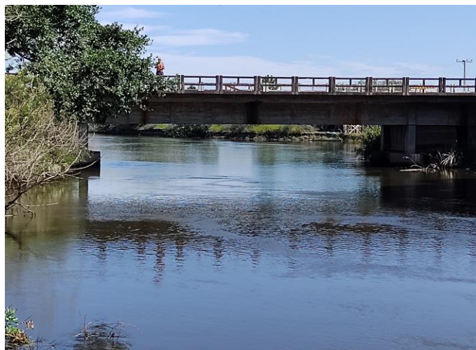
IMAGEM 01 - VISTA LATERAL DA PONTE
