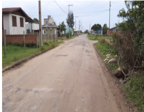
IMAGEM 02 - RUA A SER PAVIMENTADA
