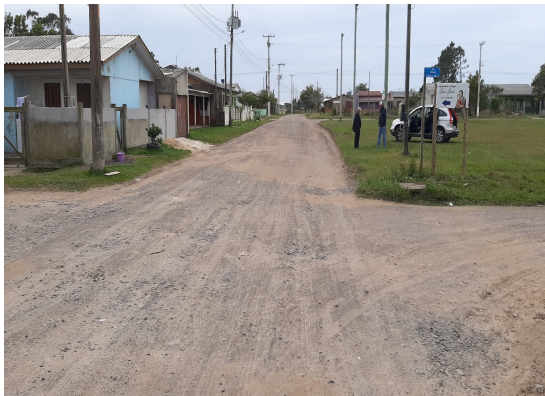
IMAGEM 05 - RUA A SER PAVIMENTADA
