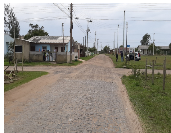
IMAGEM 04 - RUA A SER PAVIMENTADA
