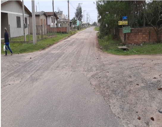
IMAGEM 01 - INICÍO DA PAVIMENTAÇÃO
