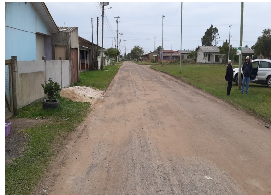
IMAGEM 06 - RUA A SER PAVIMENTADA
